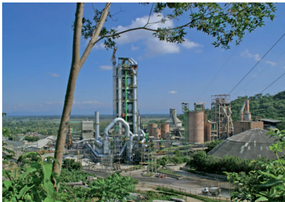
Der deutsche Großanlagenbau – im Bild ein Werk der Polysius GmbH in Honduras – ist seit jeher eine exportorientierte Branche mit einem Auslandsanteil von über 80%. Foto: Polysius GmbH
